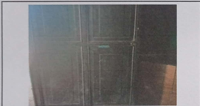
Foto 3: Sustitución de Puerta de metal
