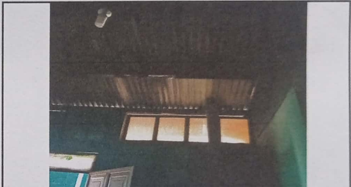
Foto 4: Cambio de venta de madera por metal
