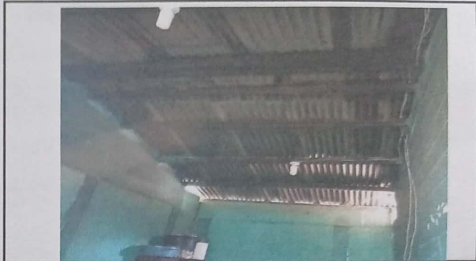
Foto 2: Sustitución de lámina
